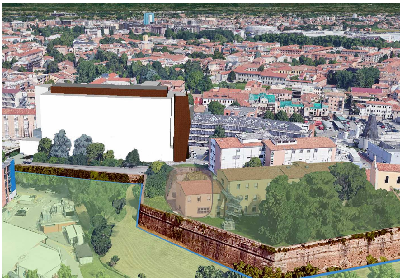
Simulazione del progetto. Volumetria schematica dedotta al progetto presentato ai VV.F. In primo piano le mura e il bastione Cornaro del Sanmicheli, con il sovrastante obsoleto edificio di Neurologia (prevista la demolizione per liberare le imponenti strutture ipogee del bastione)
